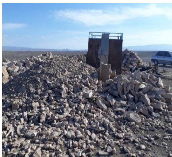
شکل ۹- رسوبات کربناتی خارج شده حاصل از لایروبی چند چاه از قنات قصبه.
