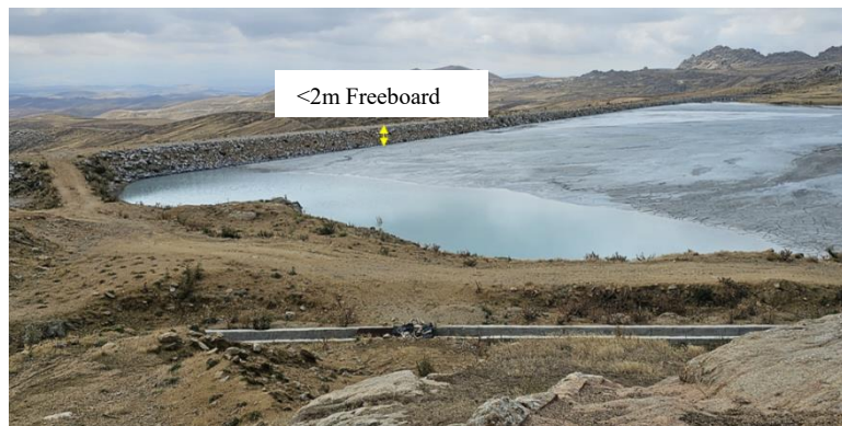
شکل ۱۳- وضعیت کنونی و تراز مواد تیل (باطله) در داخل مخزن سد. Figure 13- Current status and tail elevation inside the dam reservoir.
